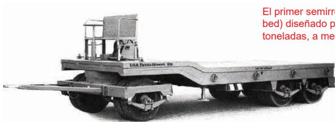
El primer semirremolque de cama baja (low-bed) diseñado para una carga útil de unas 20 toneladas, a mediados de la década de 1930.
